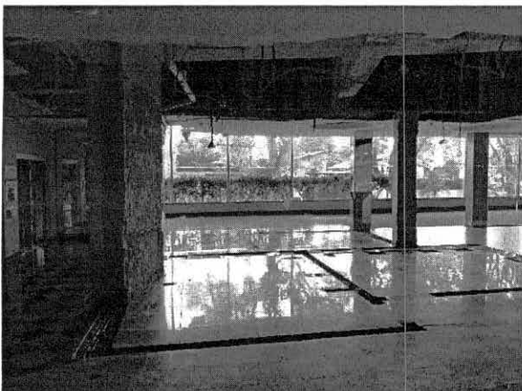
FOTO 119: TÉRREO - RESTAURANTE EM REFORMA
