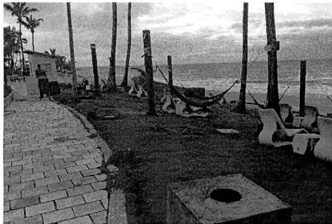
FOTO 01: ESTRUTURA DE PRAIA DO RESORT
