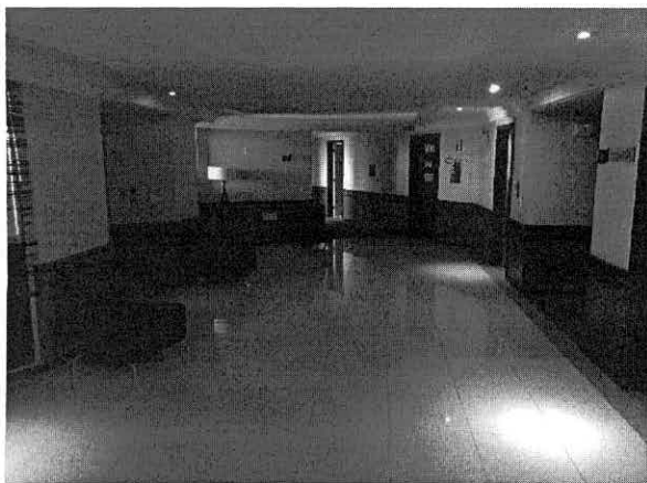
FOTO 61: 12º PAVIMENTO - HALL
