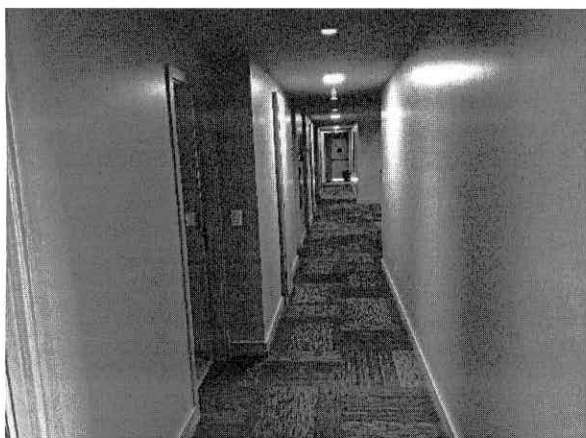
FOTO 103: TORRE 2, 3º PAVIMENTO - HALL
