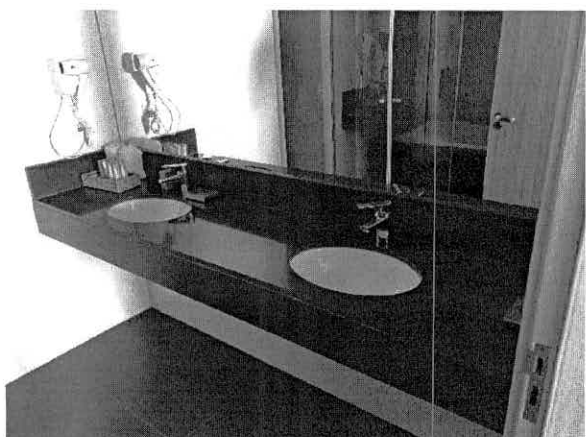
FOTO 101: BANHEIRO DA SUÍTE 245
