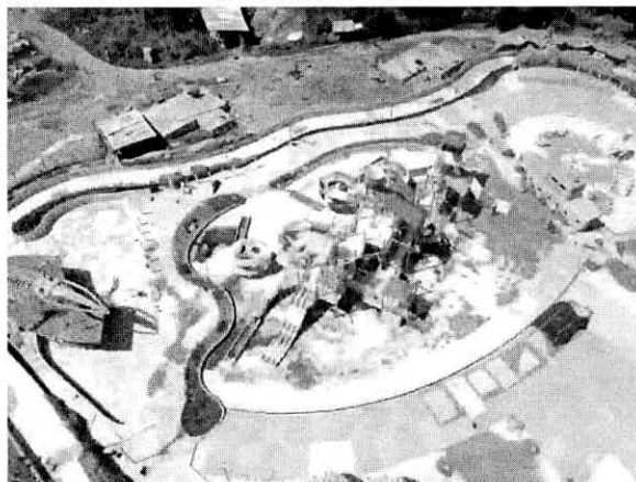
FOTO 88: VISTA AÉREA – PQ AQUÁTICO EM CONSTRUÇÃO
