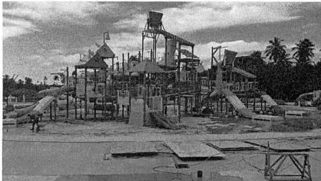
FOTO 25: PARQUE AQUÁTICO EM CONSTRUÇÃO
