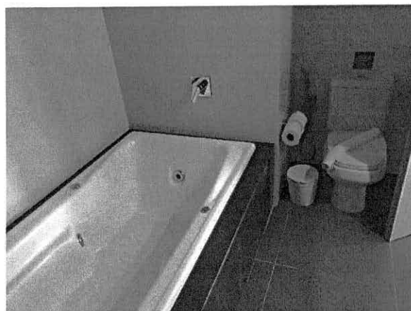
FOTO 98: BANHEIRO DA SUÍTE 244
