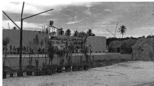
FOTO 24: PARQUE AQUÁTICO EM CONSTRUÇÃO
