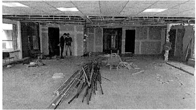
FOTO 16: SALA WYNDHAM EM REFORMA
