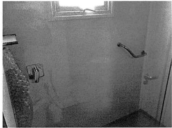
FOTO 68: BANHEIRO DA SUÍTE 335
