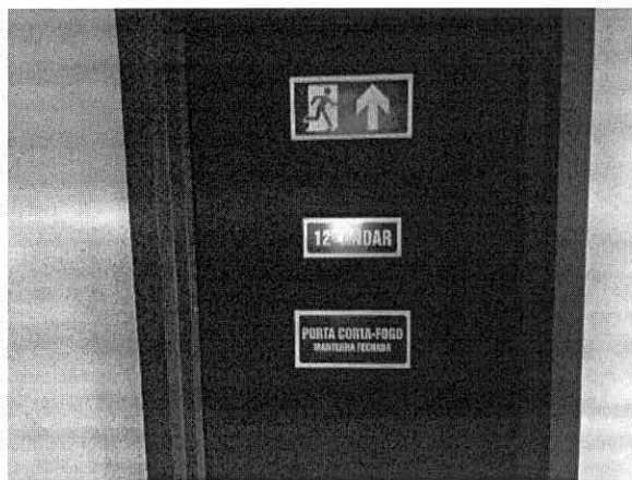
FOTO 86: 12º PAVIMENTO - SAÍDA DE EMERGÊNCIA. PORTA CORTA-FOGO
