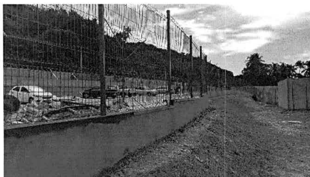
FOTO 23: PARQUE AQUÁTICO EM CONSTRUÇÃO
