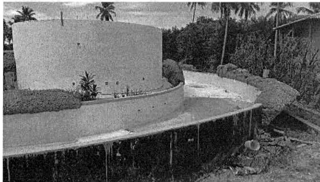
FOTO 26: PARQUE AQUÁTICO EM CONSTRUÇÃO
