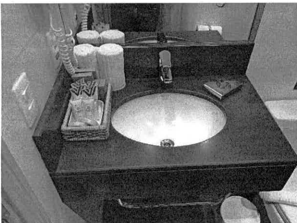
FOTO 35: BANHEIRO DA SUÍTE 121
