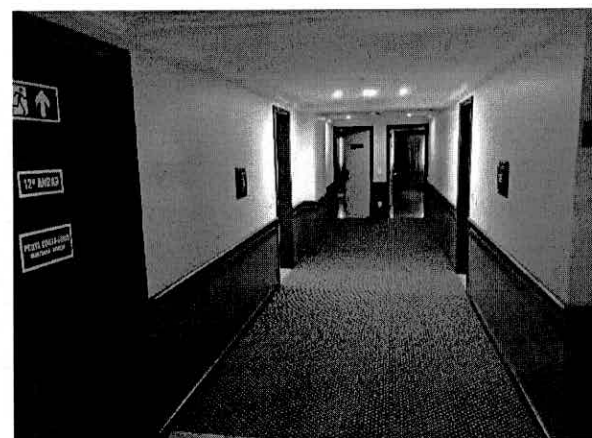
FOTO 60: 12º PAVIMENTO - HALL
